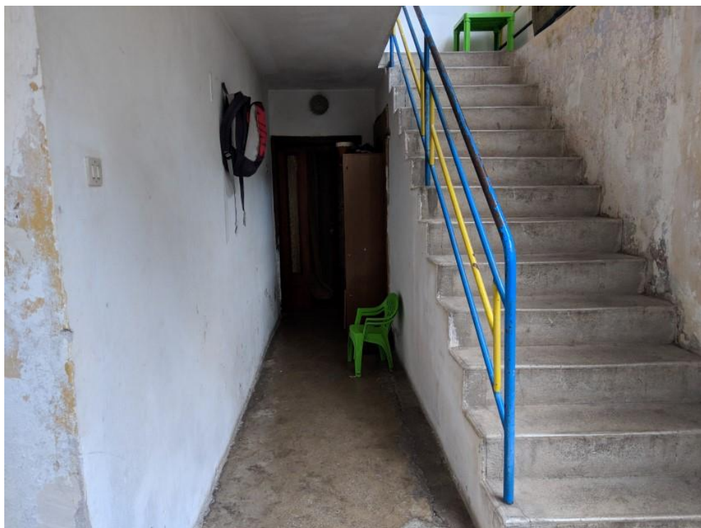
FOTO 10: CORRIDOIO E SCALE ESTERNI (P.T. – corpo principale)
