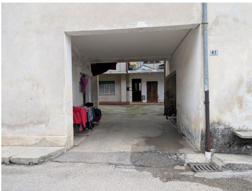
FOTO 6: PORTICATO AL PIANO TERRA
