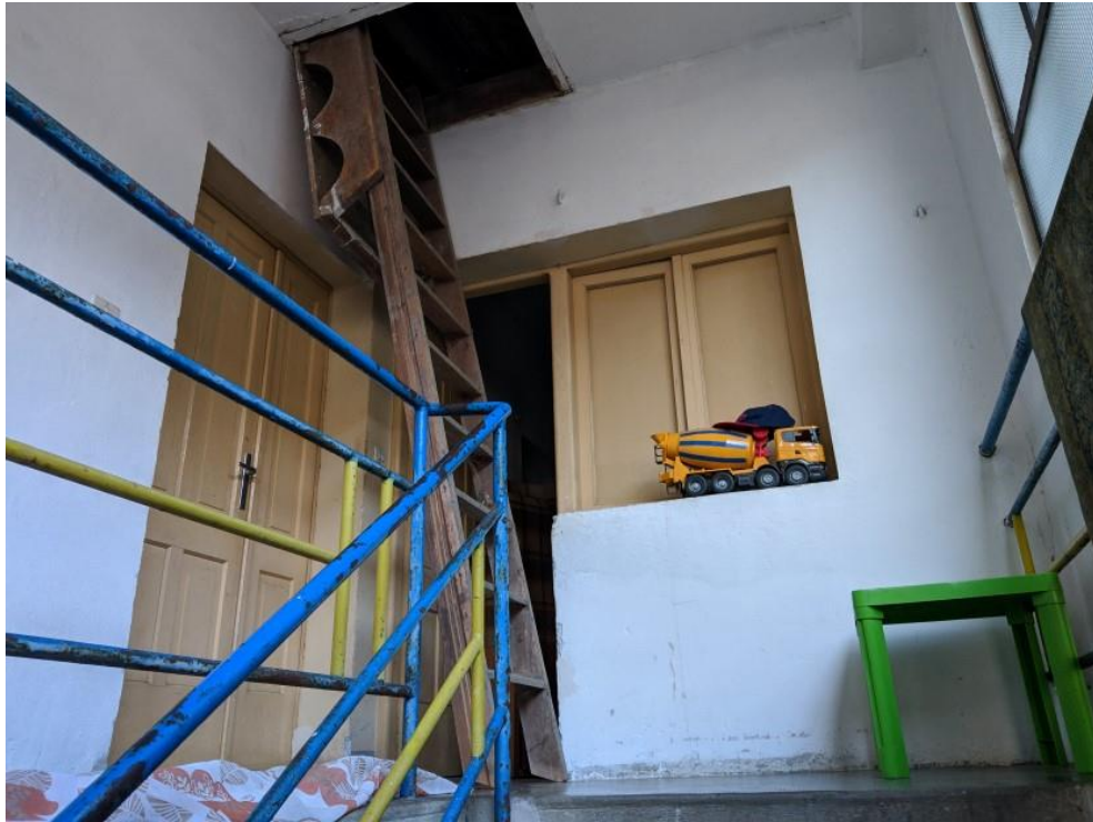
FOTO 29: SCALA ESTERNA PER ACCESSO ALLA SOFFITTA
