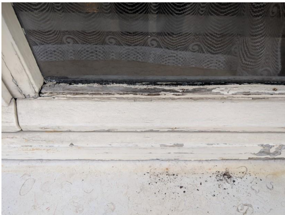
FOTO 33: PARTICOLARE DEL SERRAMENTO (FINESTRA)
