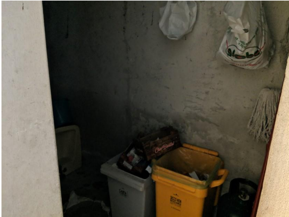
FOTO 19: RIPOSTIGLIO (P.T. – corpo accessori)
