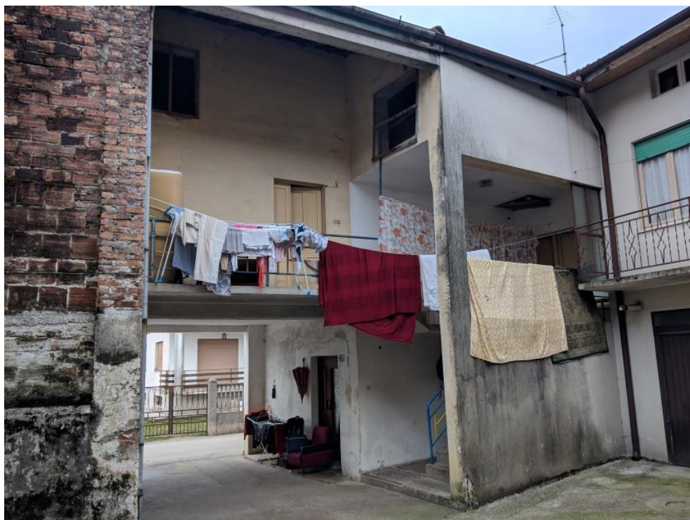
FOTO 7: PANORAMICA DEL FABBRICATO DALL'INTERNO
