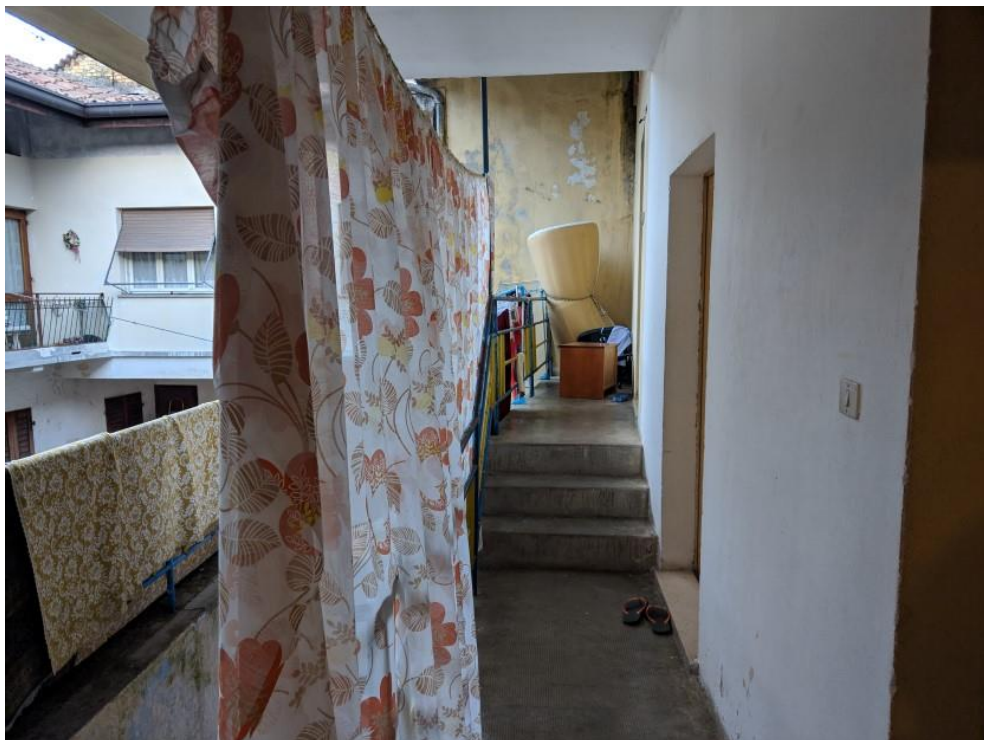
FOTO 20: DISIMPEGNO E SCALE ESTERNI (1°P.)
