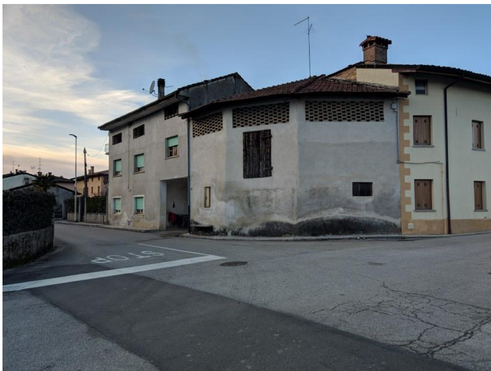
FOTO 1: PANORAMICA DEL FABBRICATO DA VIA GENERALE CANTORE
