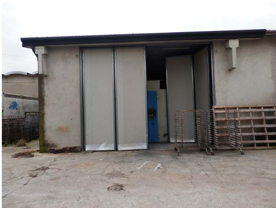
Foto 3: vista locale tettoia
