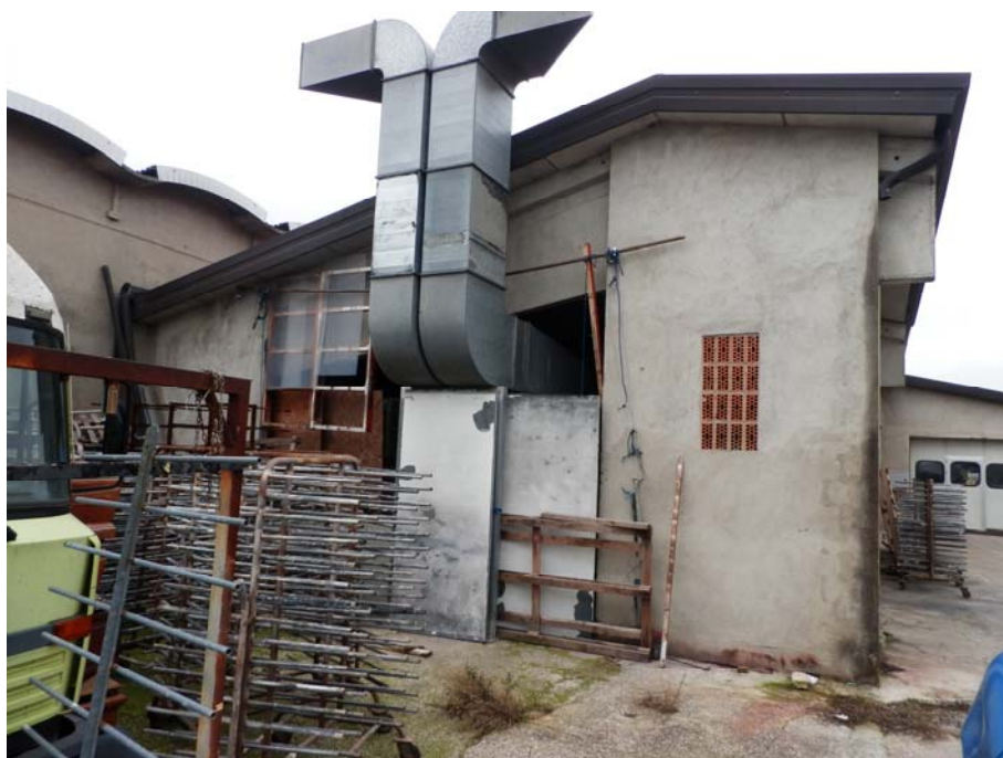
Foto 4: vista lato sud
